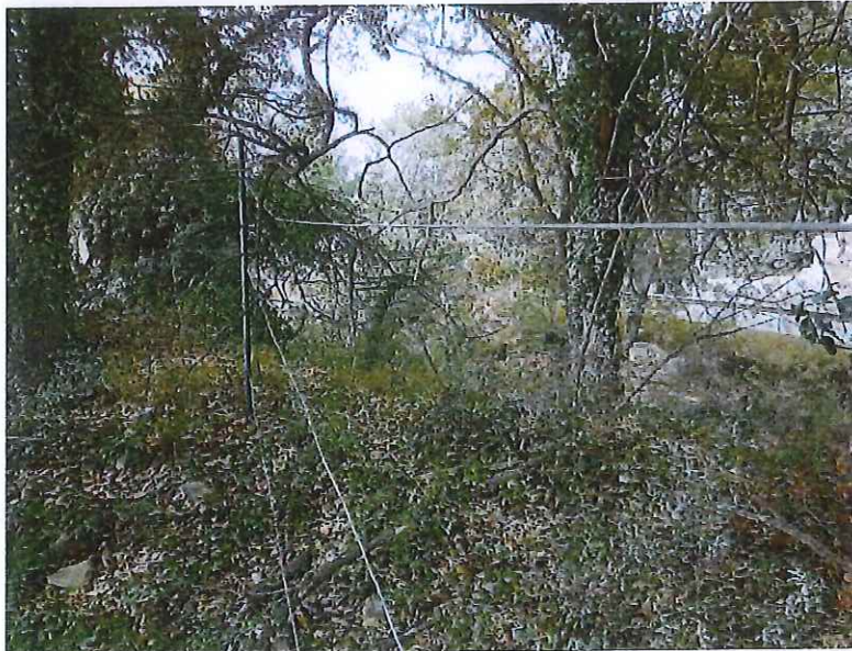
Zone de déversoir côté route
